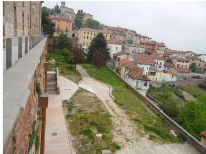
PUNTO DI VISTA B - STATO DI FATTO
