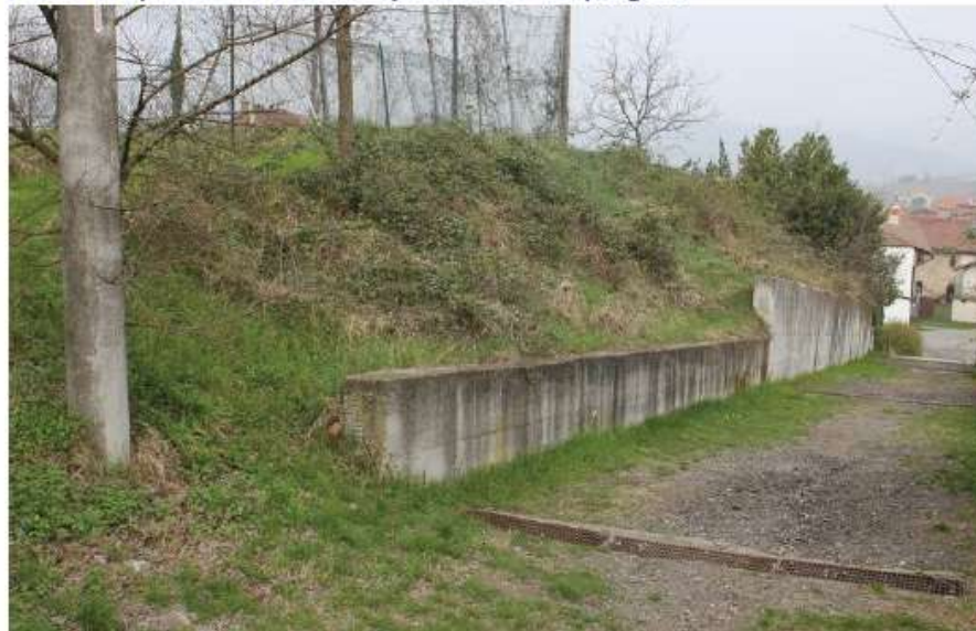
Punto di ripresa A - Foto dello stato di fatto
